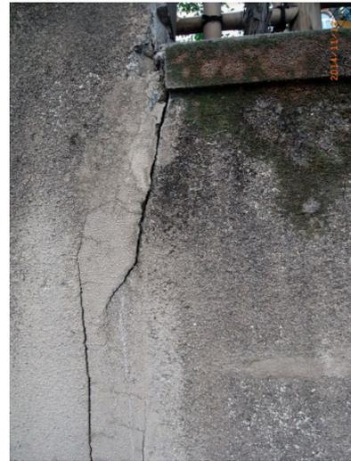
32 コンクリート塀にヒビが入っているので耐力は低下している。
