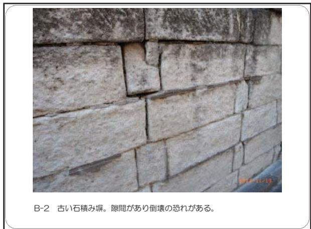
B-2 古い石積み塀。隙間があり倒壊の恐れがある。
