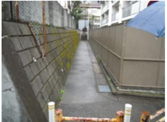
22 6段の検知ブロックの上に8段のコンクリートブロック。構造は脆弱と案ぜらる。
