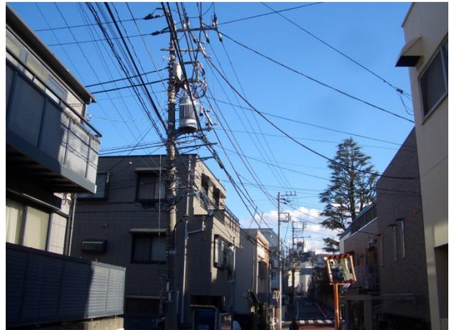
10 トランス付き電柱、通りに沿う電柱の全てがこの状態。ところどころ傾いているのが不安。
