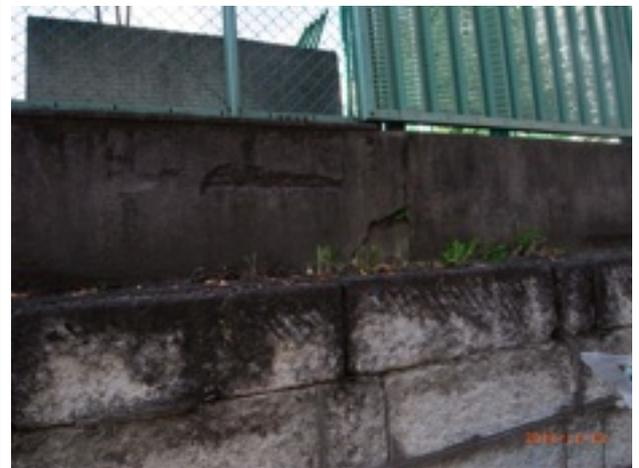
28 大谷石の上にコンクリート擁壁。傷んでいる欠損部は鉄筋の爆裂による。石もがたついている。
