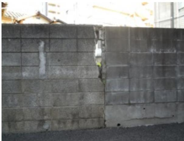
41 下 1m は擁壁扱い。土圧がかかっている。ブロック塀は損壊し、鉄筋が入っていない。
