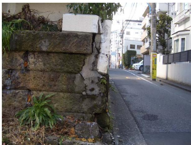
15 塀が崩れている。地震を待たず倒壊する。
