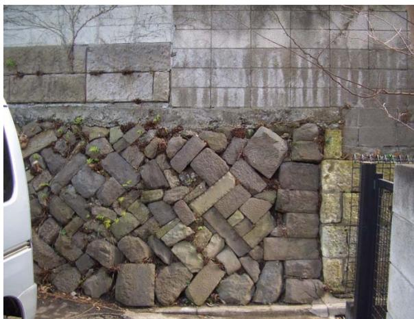
23 石積み乱尺、大谷石、ブロック積みで構成が混雑している。崩れる危険がある。
